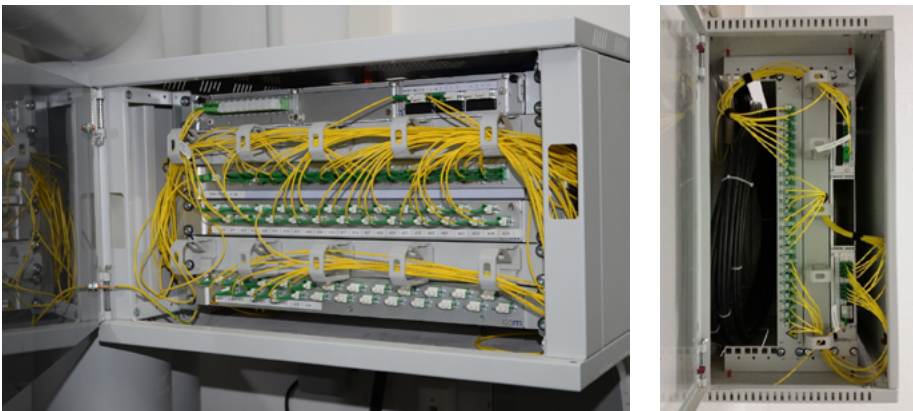
Abbildung 10: Beispiele von Glasfaser-Gebäudeverteilern (Gf-Gv) in 19 Zoll Bauweise
