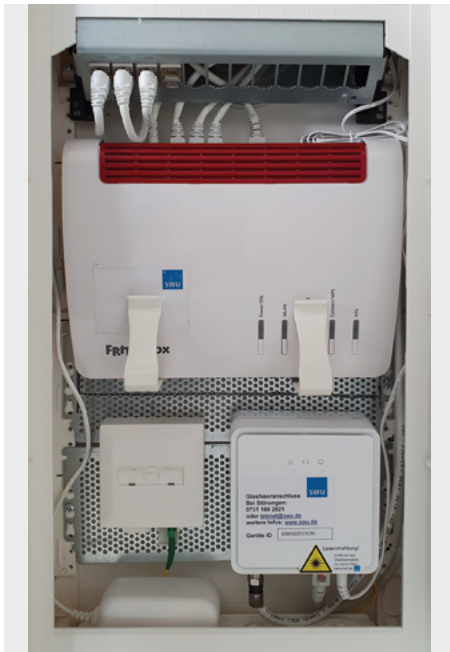
Abbildung 4: Multimediateiler bestückt (Quelle: Fa. Hager)
